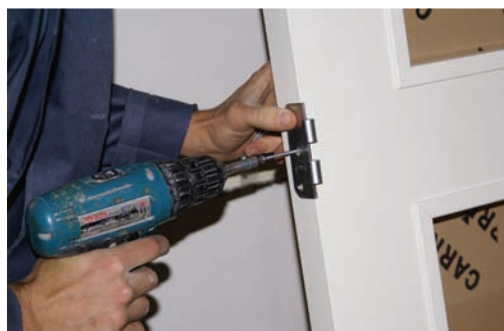
Atornillar parte de la bisagra en la hoja. Bolt other part of hinge to the leaf. Visser part de charnière au vantail.
