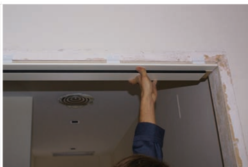
Colocación jambas alrededor del premarco. Collocation of jambs around the base frame. Mise des jambes autour du cadre.
