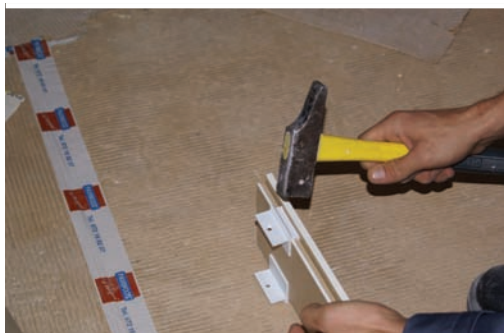
Colocar piezas de sujeción oculta. Place invisible fixation. Placer fixation invisible.
