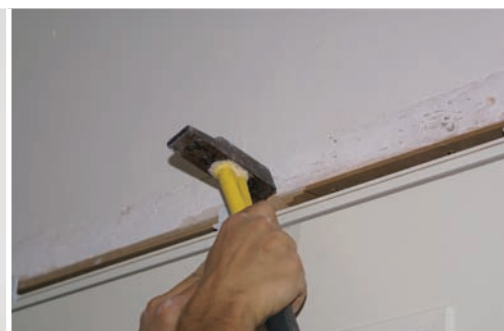
Nivelar jambas. Planish the jambs. Niveler les jambes.
